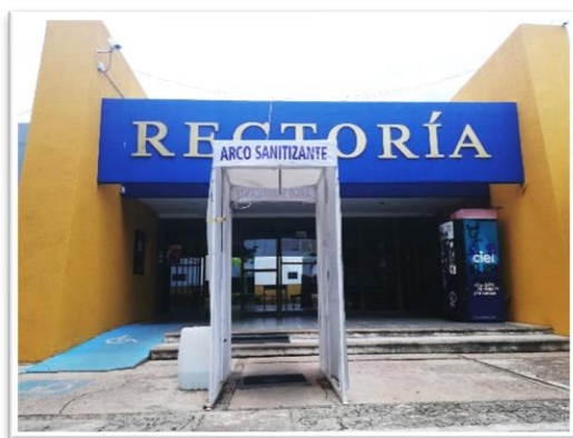
Imagen 6.-Arcos Sanitizante ubicadas en la entrada principal de Rectoría.
